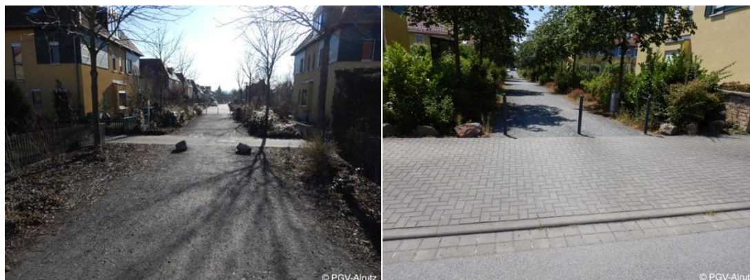
Abb. 35: Ungesicherte Steine und Poller in der Karl-Marx-Straße
