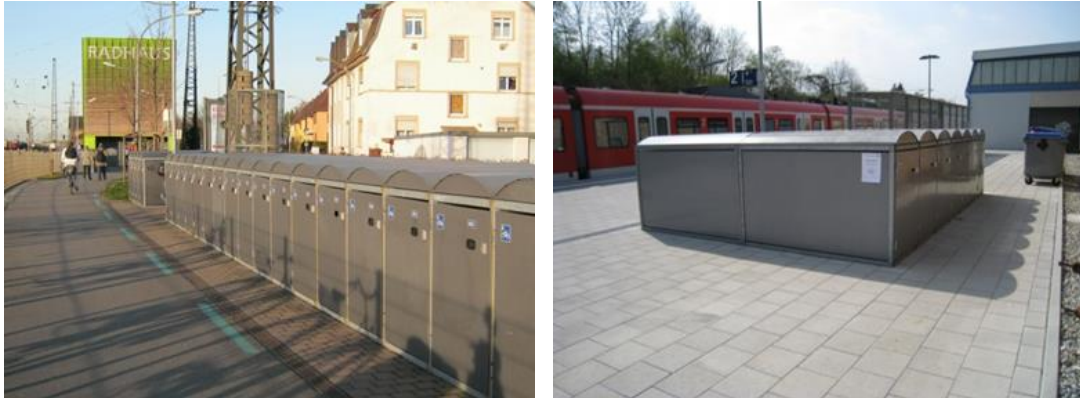
Abb. 51: Beispiele für Fahrradboxen an Bahnhöfen in Offenburg (links) und Kirchheim unter Teck
