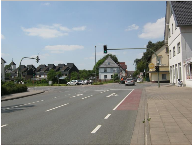
Abb. 22: Vorbeifahrstreifen in einer signalisierten Knotenpunktzufahrt (Bielefeld)
