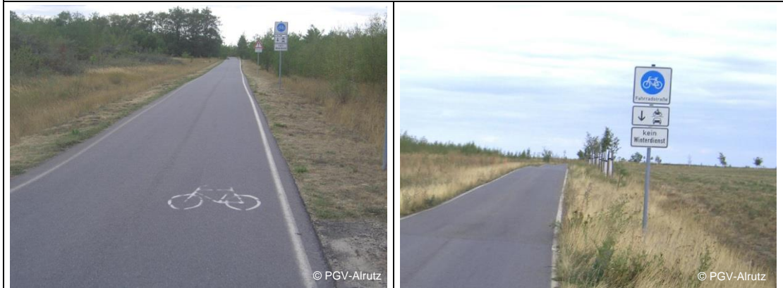
Beispiel Lausitz (Brandenburg) Fahrradstraße außerorts, z.T. mit Freigabe nur für landwirtschaftlichen Verkehr
