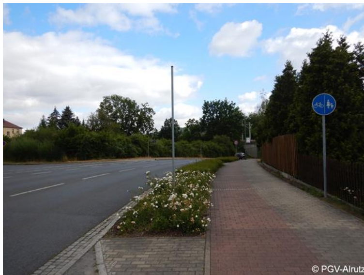
Abb. 10: Benutzungspflichtiger baulicher Radweg (Radebeul, Cossebauder Straße)
