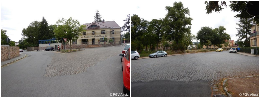
Abb. 34: Großflächig angelegte und dadurch unübersichtliche Kreuzungsbereiche (z.B. Paradiesstraße/ Winzerstraße/ Schuchstraße und Dr.-Rudolf-Friedrichs-Straße/ Wilhelmstraße/ Heinrich-Zille-Straße)
