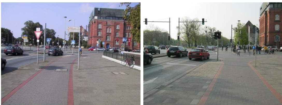
Abb. 23: Rückbau und Signalisierung eines konflikträchtigen freien Rechtsabbiegefahrstreifens in Hannover (links vorher, rechts nachher)
