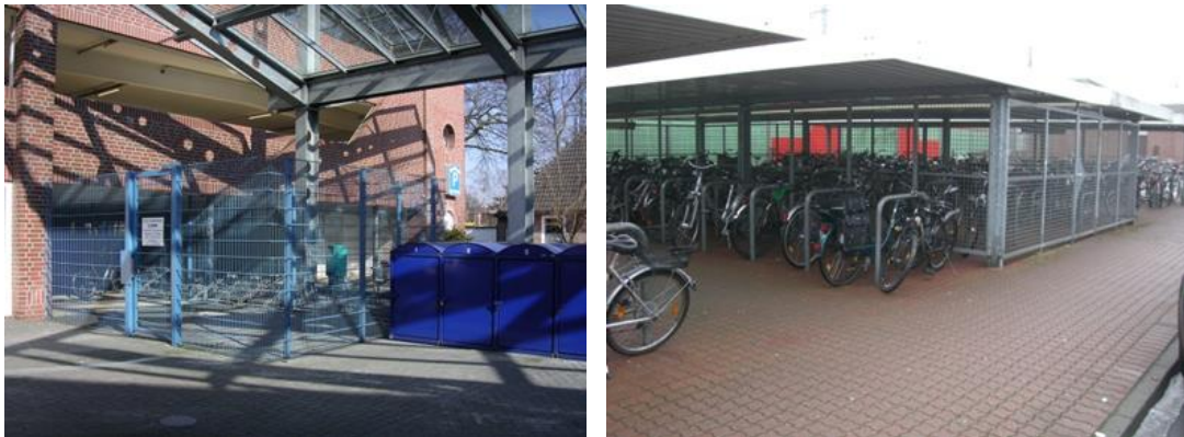
Abb. 52: Beispiele für Fahrradabstellanlagen mit Umfriedung in Leer (links) und Lehrte (rechts)
