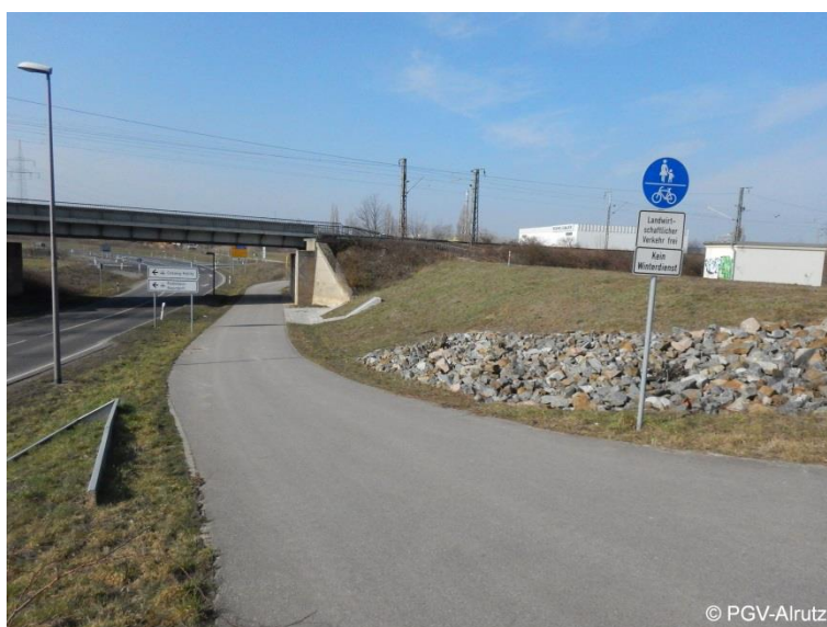
Abb. 16: Gemeinsamer Geh- und Radweg (Radebeul, Cossebauder Straße)
