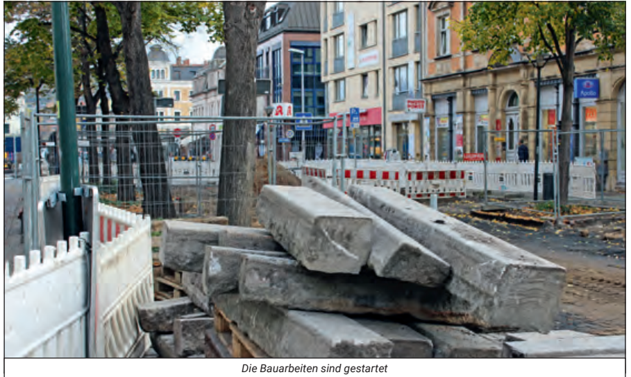
Die Bauarbeiten sind gestartet
