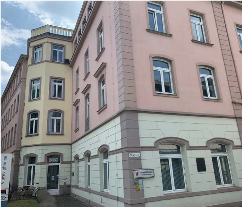
Meißner Straße 35 nahe der Stadtgrenze zu Dresden: Ehem. Chemische Fabrik von Heyden, später VEB Arzneimittelwerk Dresden. 1875 die weltweit erste pharmazeutische Produktion im industriellen Maßstab. Das Fabrikations- und Verwaltungsgebäude im Bild von 1900/1912. Heute Arevipharma.
