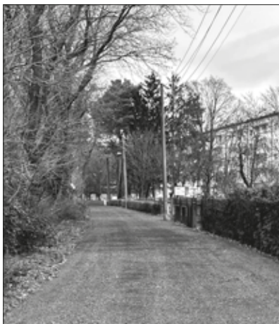
Der instandgesetzte mittlere Abschnitt der Straße des Friedens
