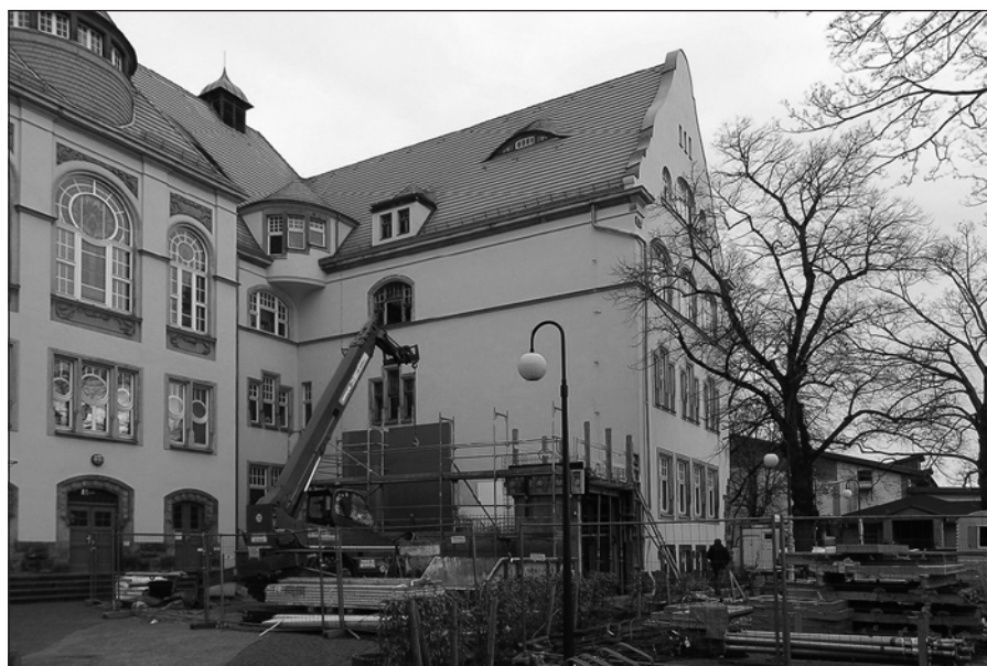
Seit November 2020 wird das Treppenhaus (2. baulicher Rettungsweg) mit Aufzug ertüchtigt. Zu diesem Zweck sind derzeit Ortsbetonarbeiten des gebundenen Baubetriebes, der BAUHAUF GmbH aus Coswig im Gange.
