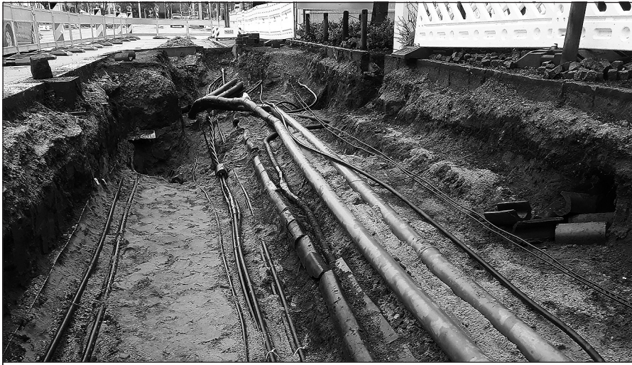
Zahlreiche Leitungen verschiedenster Medienträger verbergen sich unter der Meißner Straße und müssen neu geordnet werden.
