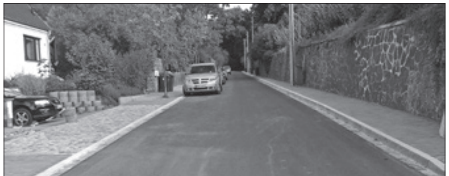
Zustand nach Ausbau 2014
