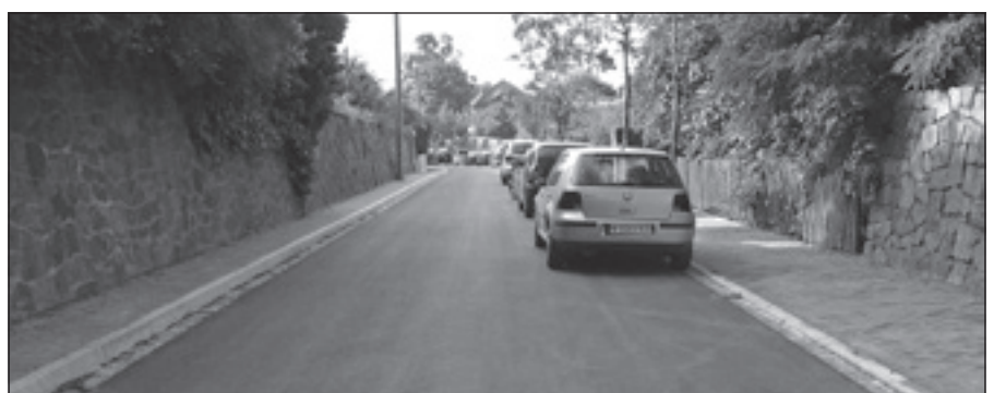
Zustand nach Ausbau 2014
