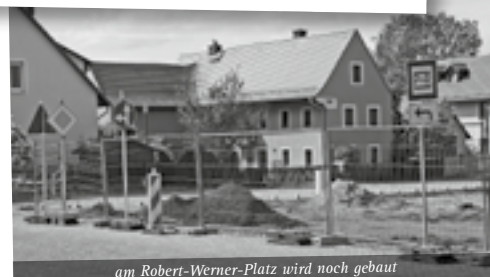
am Robert-Werner-Platz wird noch gebaut
