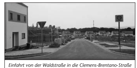
Einfahrt von der Waldstraße in die Clemens-Brentano-Straße
