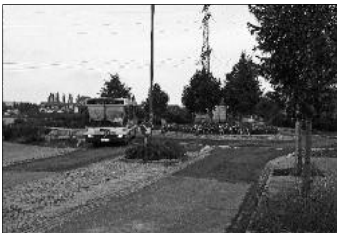
Die Firma Swietelsky erneuerte grundhaft die Kreisfahrbahn und die Verbreiterungen der Zu- und Ausfahrten. Die Bordanlagen, die Straßenentwässerung sowie die Dränagen wurden ebenfalls erneuert (Kosten: ca. 100.000 €). Außerdem musste eine Schutzrohrtrasse der Telekom, welche den Kreisverkehr quert, aufwendig tiefer gelegt werden. Seit dem 15. 8. 2011 kommen v.a. die LKWs besser durch den Kreisverkehr in Naundorf.
