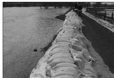
Sandsäcke sichern den Damm
